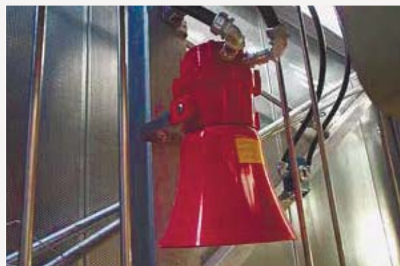
Звуковой сигнал тревоги в газовой электростанции. 🔊-звукоизлучатель VExS 120 ATEX.
