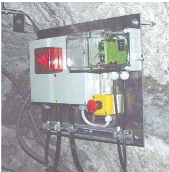
Иллюстрация: компактная проблесковая лампа PY X-S-05 в туннеле. Диапазон входного напряжения: 70–240 В AC, 73–140 В DC (питание от сети и от аккумулятора)
