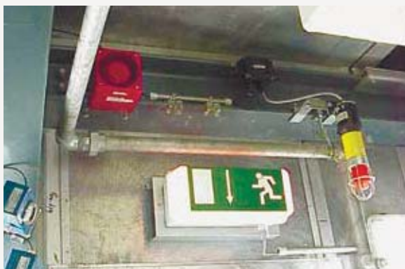
Газоанализатор со световым и звуковым сигналом тревоги. 🔊 звукоизлучатель DS 10 ATEX и 🟡 проблесковая лампа CWB-ATEX.
