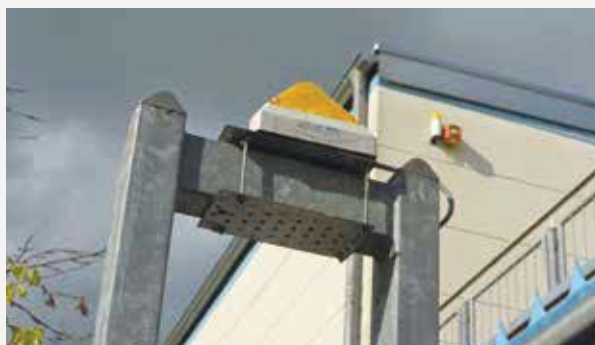
Проблесковые лампы Pfannenberg PYRA-M и ABL, оповещатель DS для охраны ворот и пожарной сигнализации
