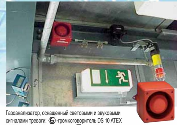
Газоанализатор, оснащенный световыми и звуковыми сигналами тревоги:
